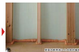
壁面内断熱施工と内部防蟻施工
